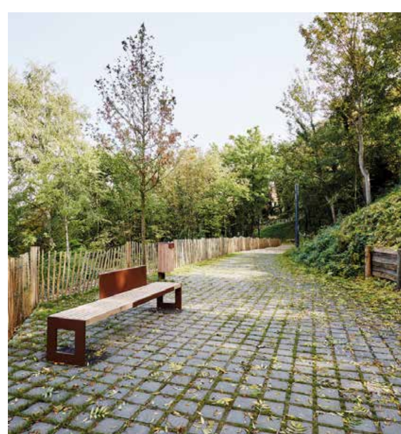
Verharding kan ook waterdoorlatend zijn: zo voorkom je dat water naar het riool vloeit
